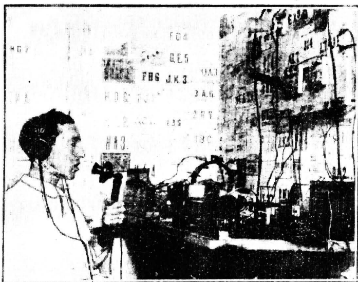
Fig. 59 : La estación 814 –número dado por el Radio Club Argentino– de Domingo Lavizzari en 1925. El micrófono de carbón –un candelero “Frost”– era elemento obligado para trabajar en radiotelefonía en esos años.
